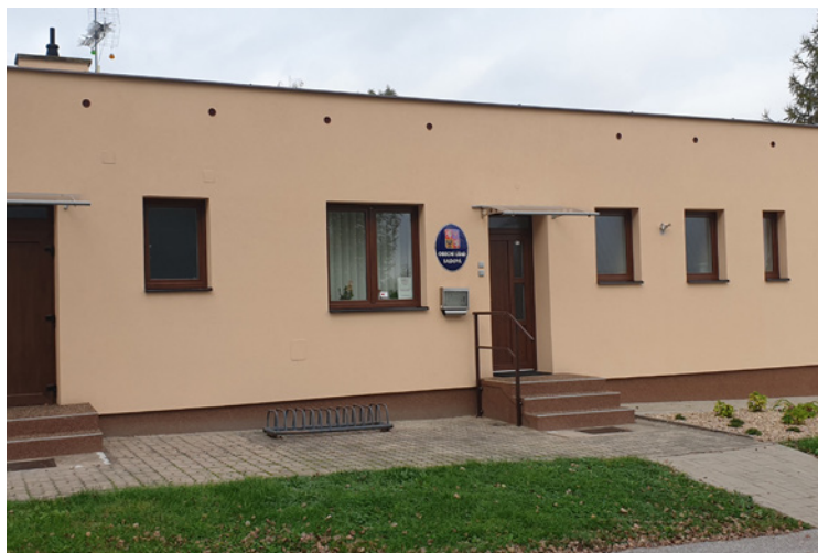
▪ Budova obecního úřadu po rekonstrukci. Foto: Dušan Jedlička
