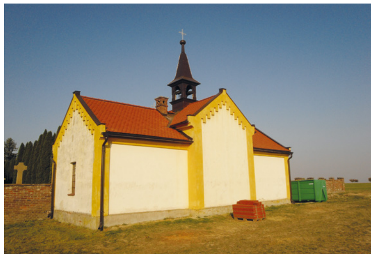
▪ Probíhající rekonstrukce márnice. Foto: Petr Švasta
