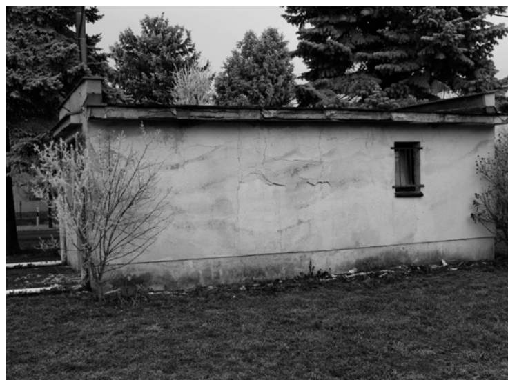
▪ Hasičská zbrojnice před rekonstrukcí. Foto: Irena van Vuurenová
