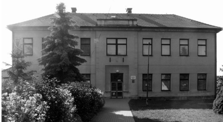
▲ Budova MŠ Třesovice před rekonstrukcí 2015. Foto: P. Mrkvička
