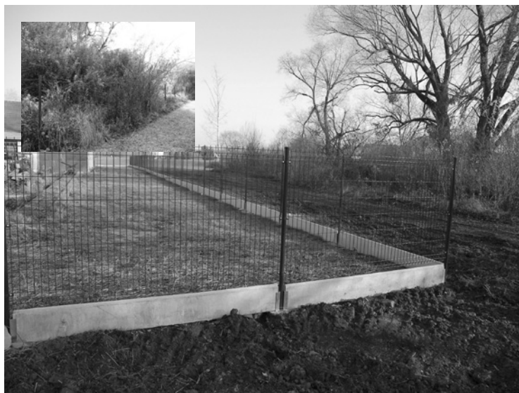
▲ Nové oplocení sběrného dvora v Sadové. Foto: Ing. Drahošlav Falta
