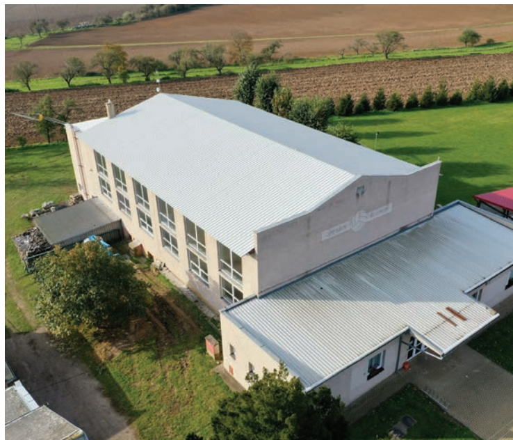
▪ Pohled na opravenou střešní krytinu z ptačí perspektivy. Foto: Přemysl Slivko
